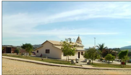
Figura 5 – Praça no entorno da Igreja, Comunidade de Serra Negra
