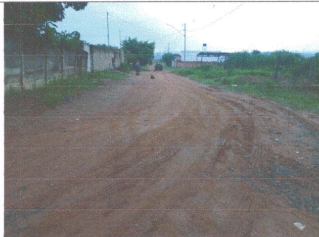
Foto 15 – Rua 06 esquina com Rua E
