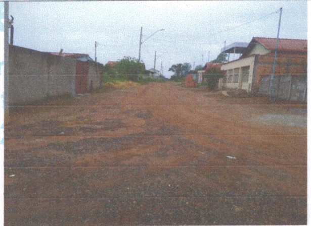
Foto 18 – Rua 05 esquina com Rua D
