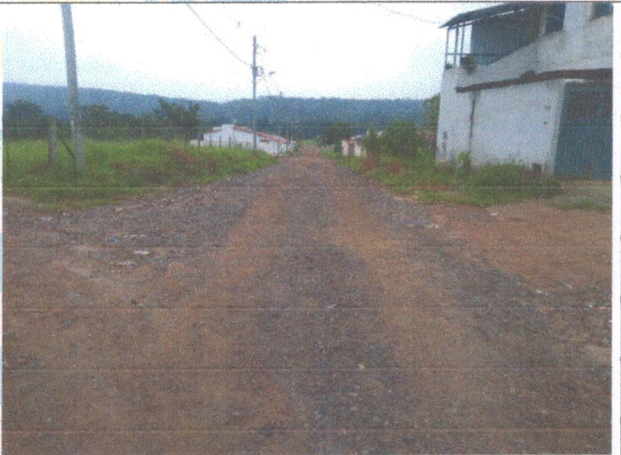
Foto 4 – Rua E esquina com Rua 05
