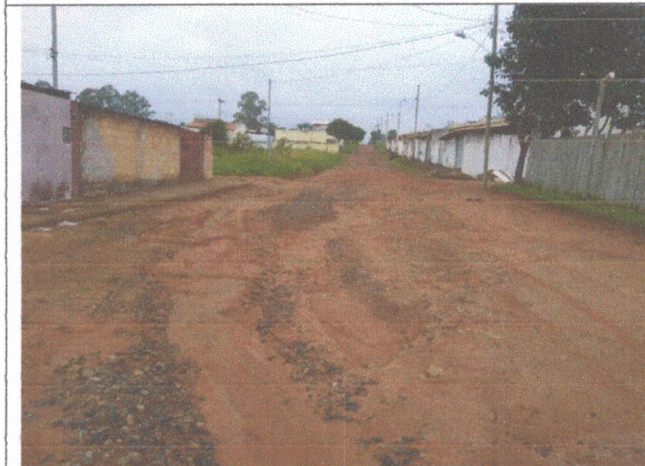
Foto 9 – Rua E final do calçamento
