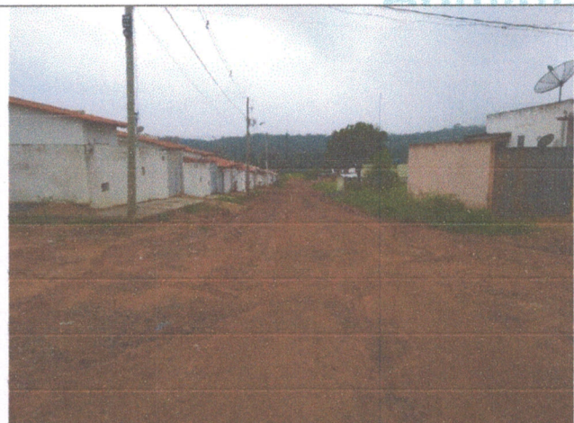
Foto 5 - Rua E esquina com Rua 04
