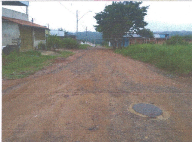
Foto 3 – Rua E esquina com Rua 06
