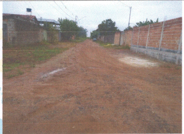
Foto 16 – Rua 06 esquina com Rua D
