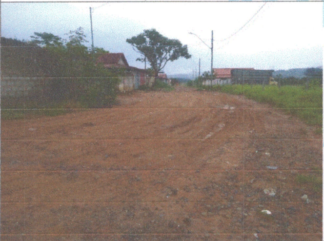
Foto 17 – Rua 05 esquina com Rua E
