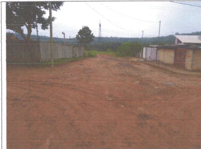
Foto 7 – Rua E esquina com Rua 02 – Sentido ETE
